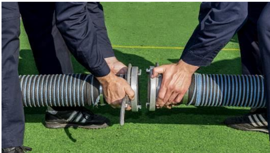
Fig.16a : Raccordement des tuyaux d'aspiration par l'équipe d'eau WTR et l'équipe de tuyau STR
